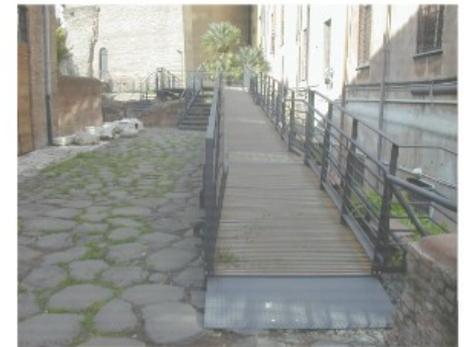
Esempio di rampa di accesso a edificio pubblico realizzata con materiali come quelli esistenti nell'edificio di Isola di Fondra (ferro-legno)
