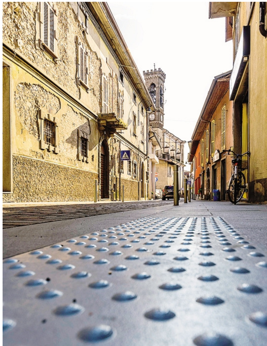
La pavimentazione tattile in via Colleoni a Scanzorosciate FOTO PERSICO
