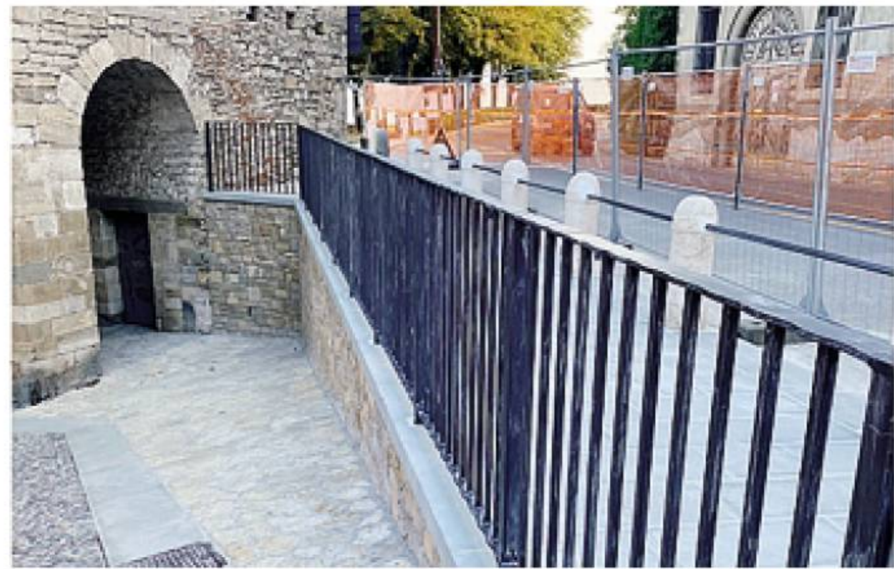
La ringhiera installata a Porta San Giacomo
