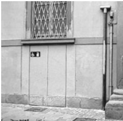
Un esempio di intervento ben riuscito su un edificio storico: l'ascensore è mimetizzato nella facciata usando lo stesso intonaco del muro
